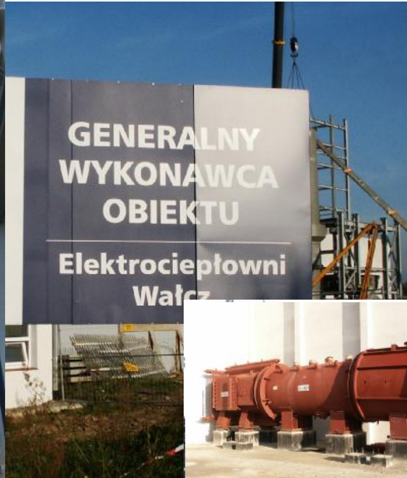
Pyrolysegasnutzung / Gaskessel / Dampferzeuger
