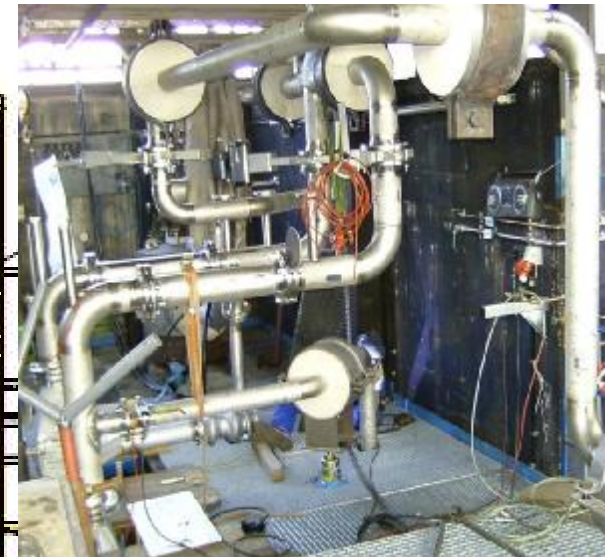
Montage der Heißgasrohrleitungen
