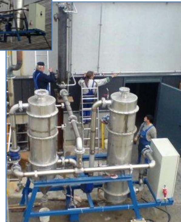
Montage der chem. Brenngasreinigung ; V = 200 \text{ m}^3/\text{h}
