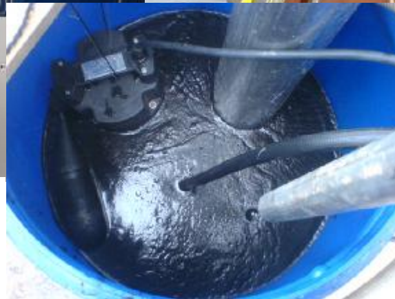
Rußschlamm aus Gasreinigungsanlage
