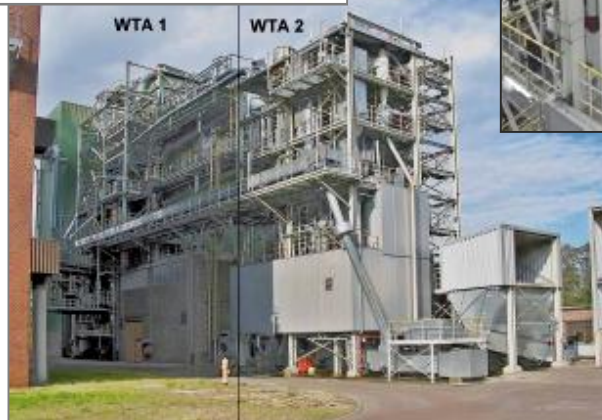
WTA-Anlagen am Standort in Frechen
