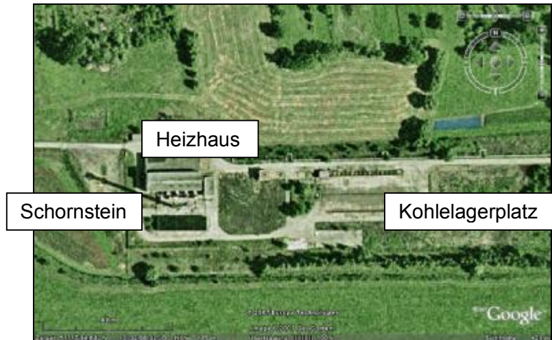
Abbildung 8: Kraftwerksstandort – Großenhain (OT Naundorf)
