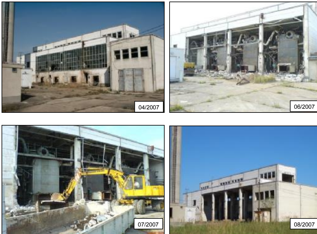
Abbildung 14: Arbeiten zum Rückbau der Dampfkesselanlagen im alten Heizhaus Lautex
