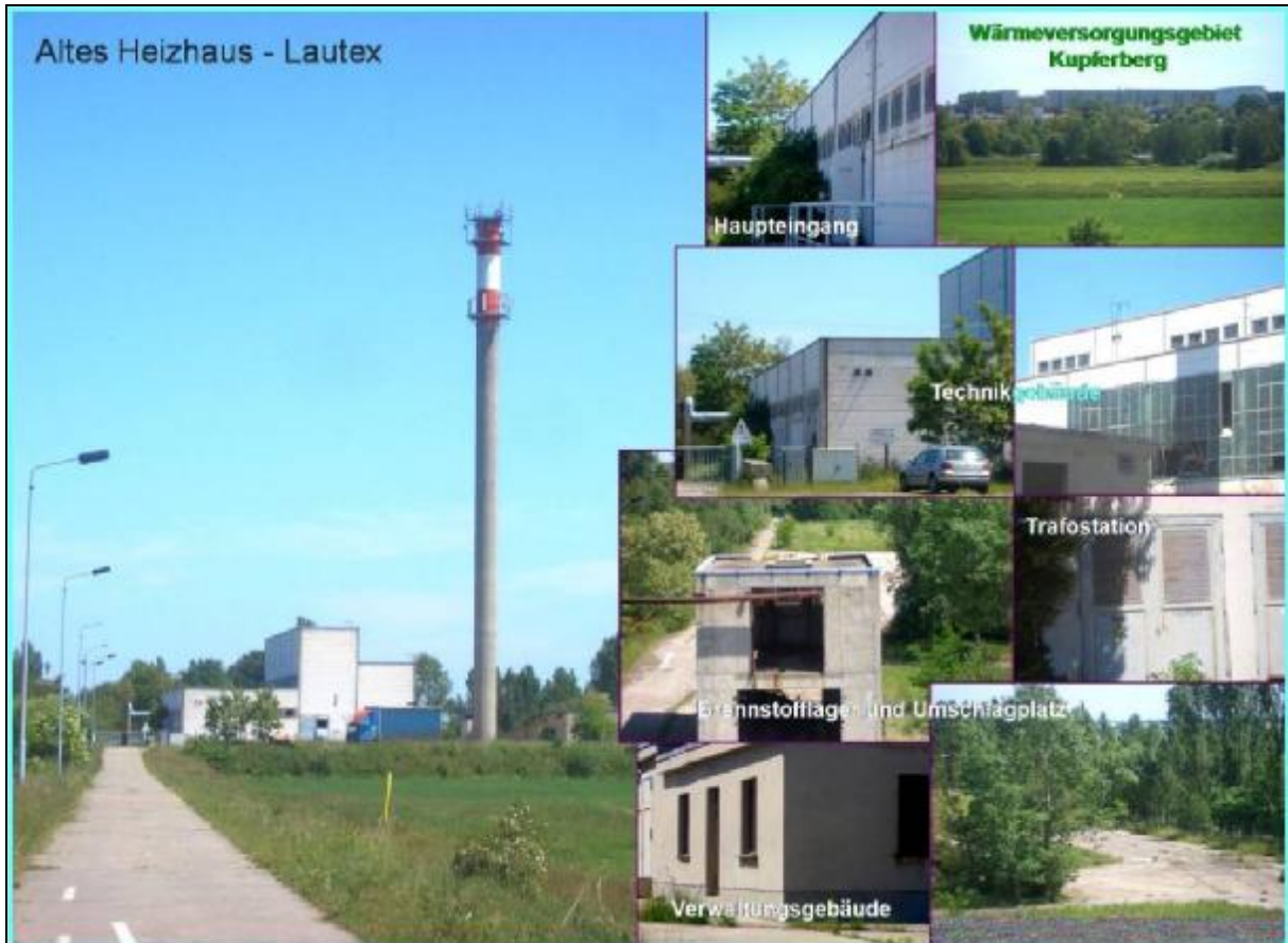
Abbildung 13: Objekt „Altes Heizhaus-Lautex“ April 2007
