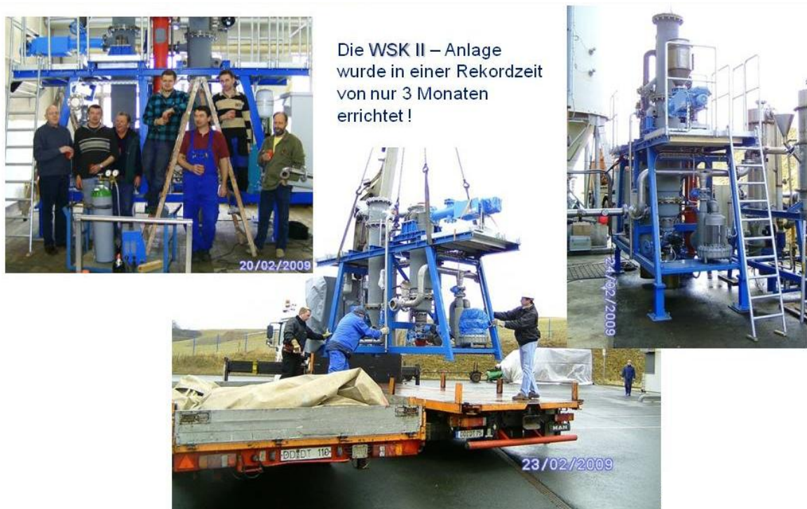
Bild D: Wirbelschichtkühler, WSK 2
