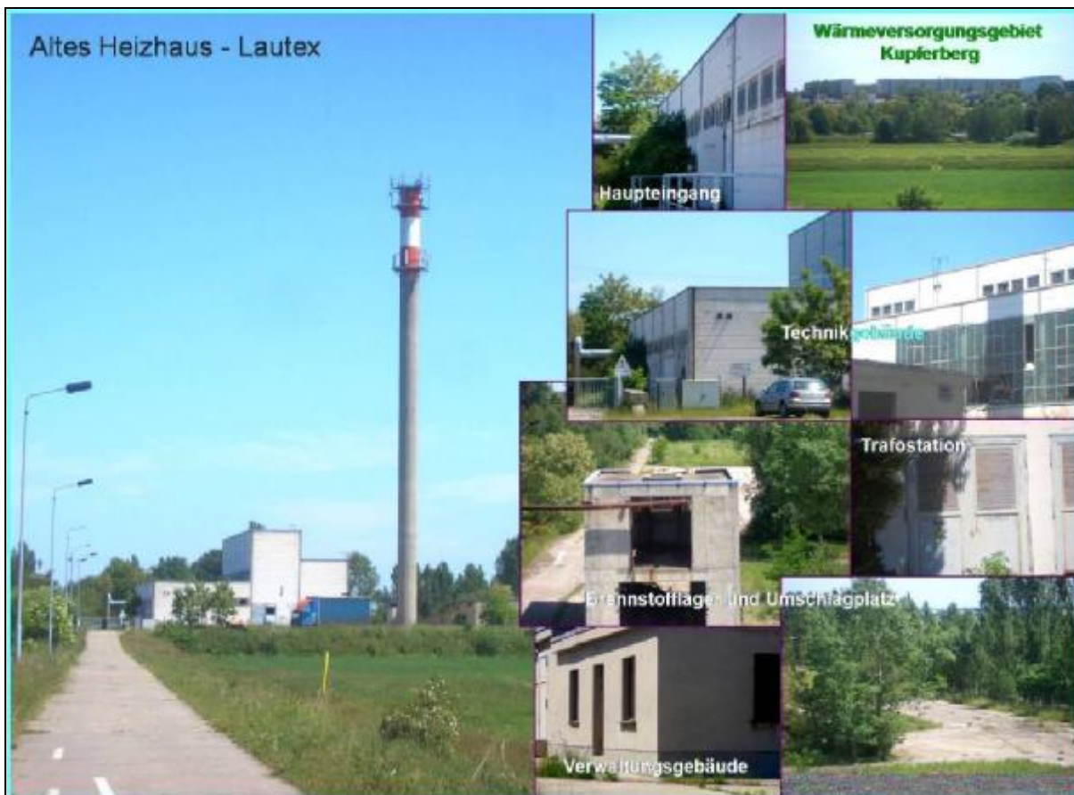
Abbildung 13: Objekt „Altes Heizhaus-Lautex“ April 2007
