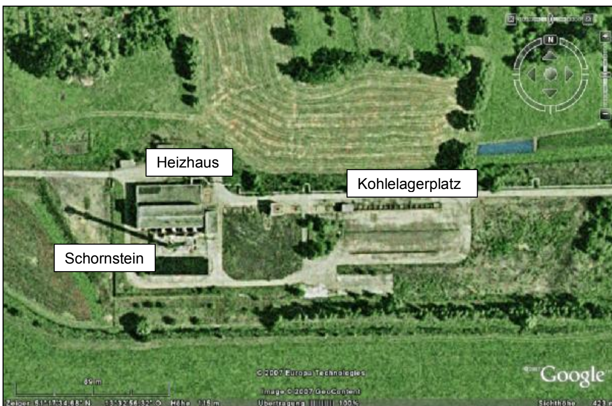
Abbildung 8: Kraftwerksstandort – Großenhain (OT Naundorf)
