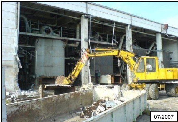
Abbildung 14: Arbeiten zum Rückbau der Dampfkesselanlagen im alten Heizhaus Lautex
